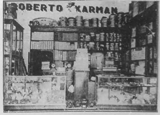
Aspecto interior de la casa R. Karman, en Cienfuegos. La casaca de Roberto Karman tiene una admirable provisión de efectos eléctricos y mecánicos y la seriedad de sus transacciones y sus inmejorables materiales la hacen ocupar un puesto prominente entre las de su giro.
